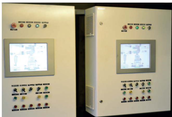
Рис. 2. Шкафы автоматики пресс-гранулятора с отображением мнемосхемы
